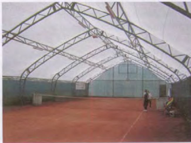
Fig. 1 Exemplificare tipuri de acoperiri pe structuri modulare realizate cu membrane multistrat SIOEN
